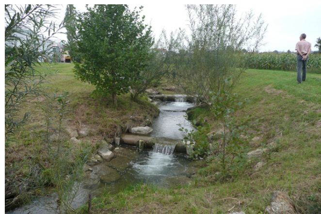
Thomas Oesch begutachtet eine geglückte Revitalisierung am Wändhülsenbach in Bubikon ZH.
